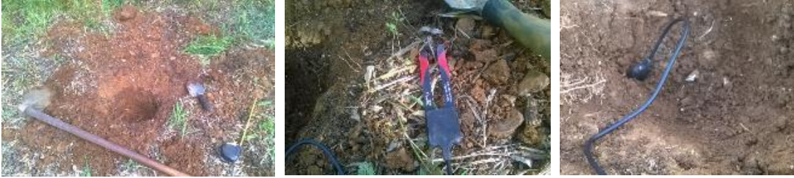
Εικόνα 7 Εγκατάσταση αισθητήρων εδάφους
